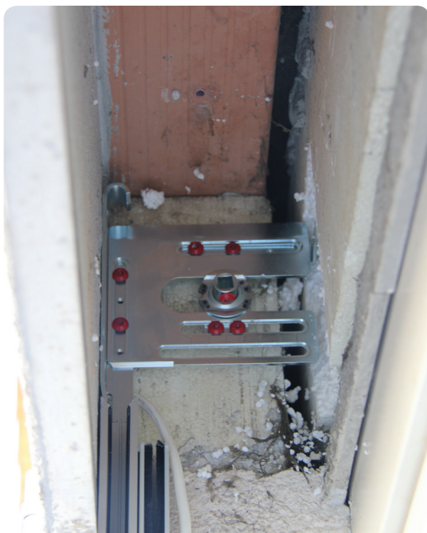
Abb. 105: Montage von Ecomont in Lamellensturz 150 mm – Nischenansicht
