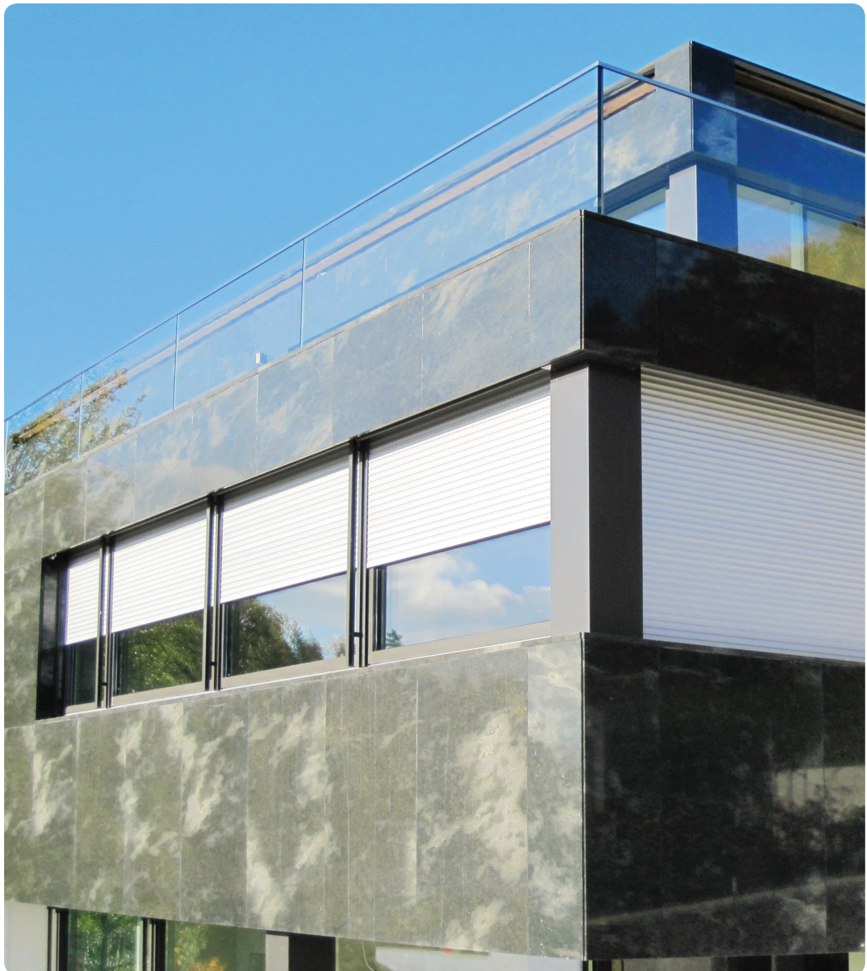
Abb. 17: Rollläden im bauseitigen Sturz
