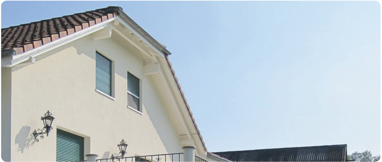
Abb. 82: Einbau in bestehenden Hohlsturz
