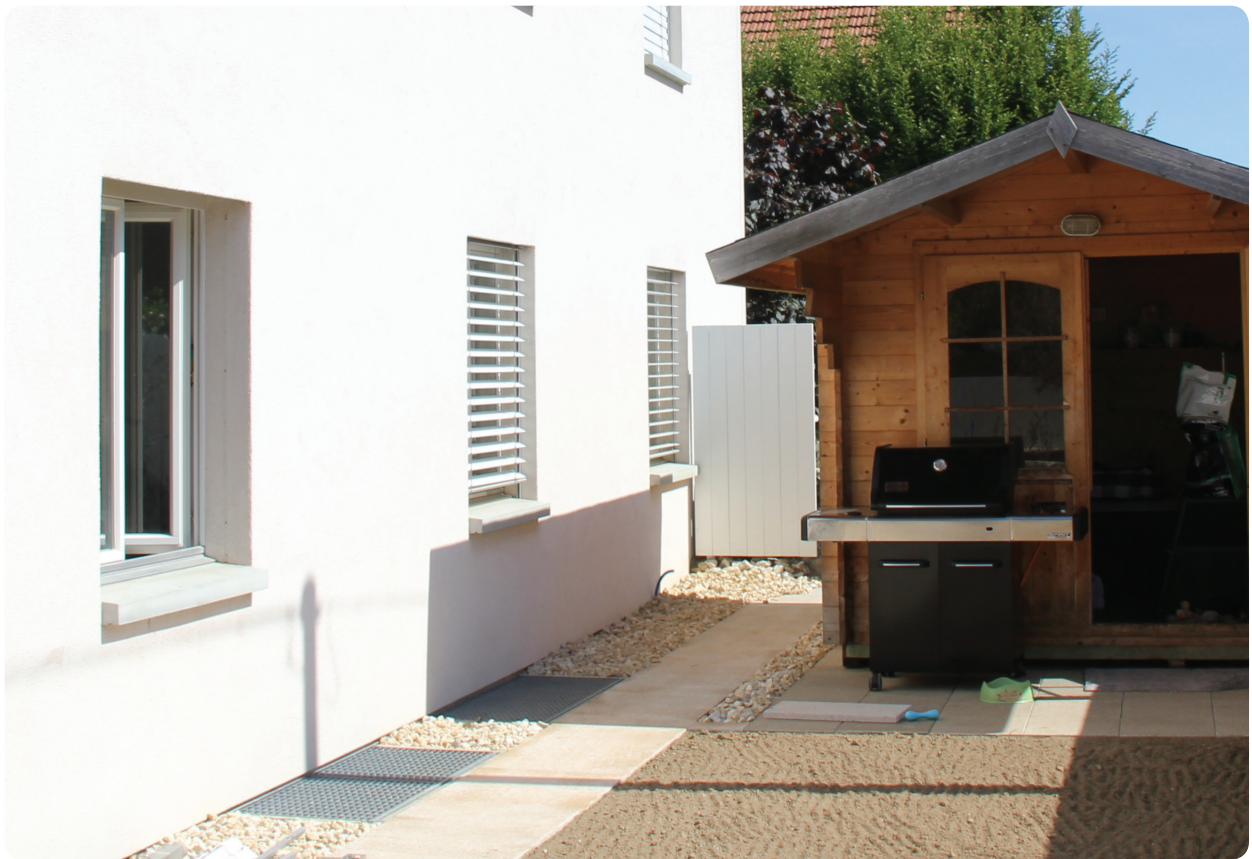
Abb. 106: Montage von Ecomont – vorher
