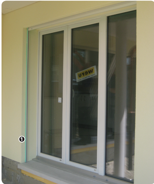
Abb. 80: Ecomont mit geteilter Führungsschiene – Phase 2
