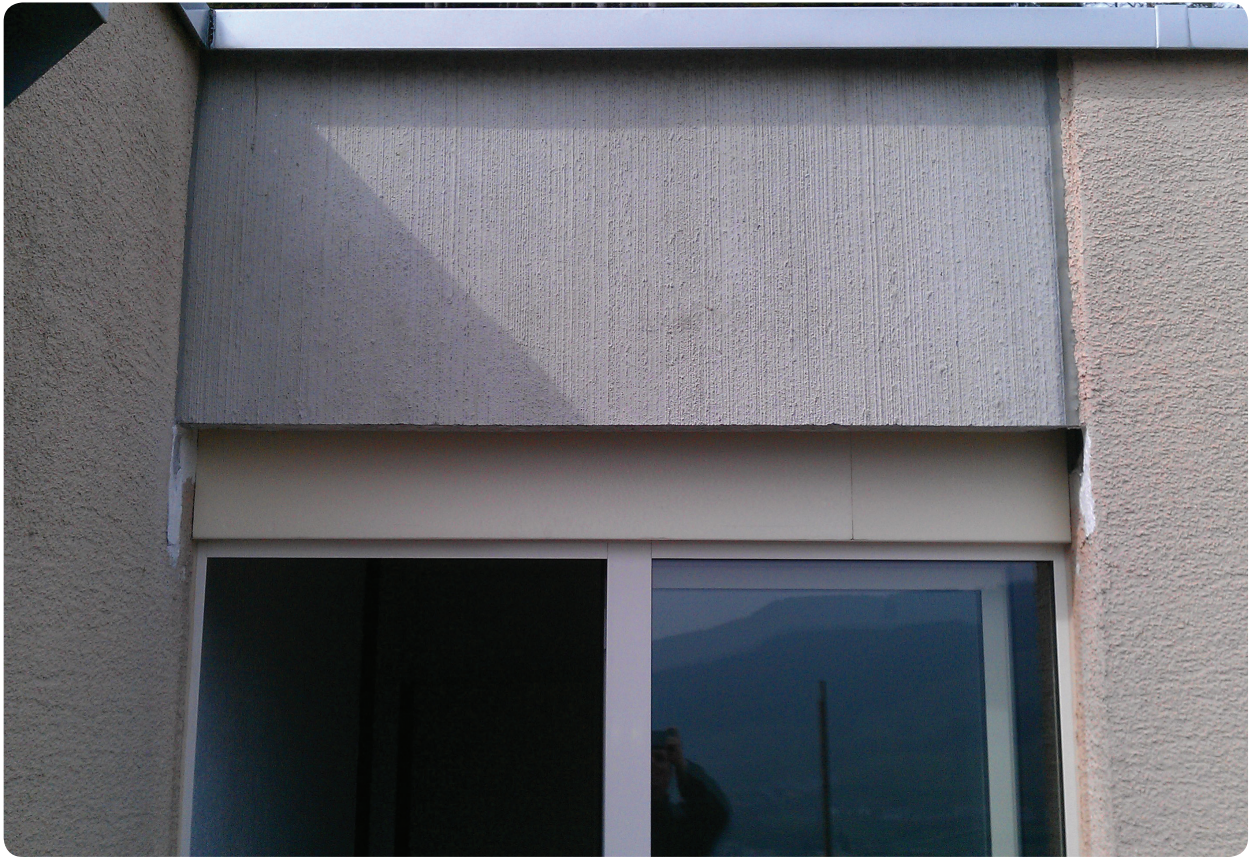
Abb. 111: Blende Lamellenhohlsturz entfernt
