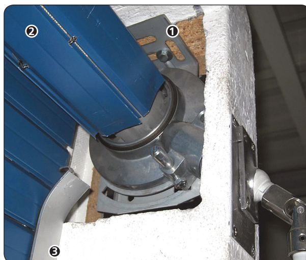
Abb. 75: Konventionelles Einbausystem der Firma Regazzi SA mit Kegelradgetriebe
