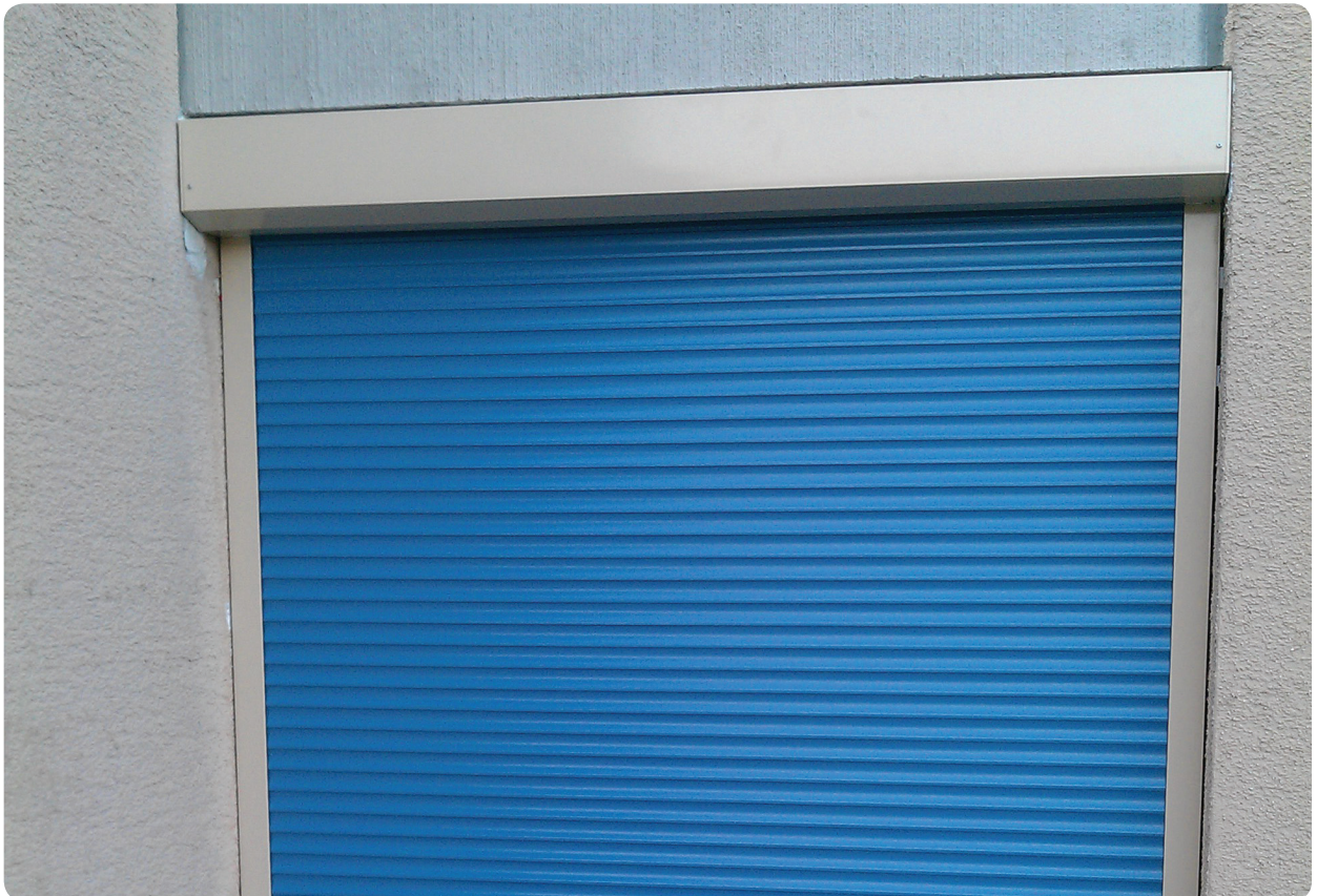
Abb. 112: Kassettensystem montiert (Situation nachher)
