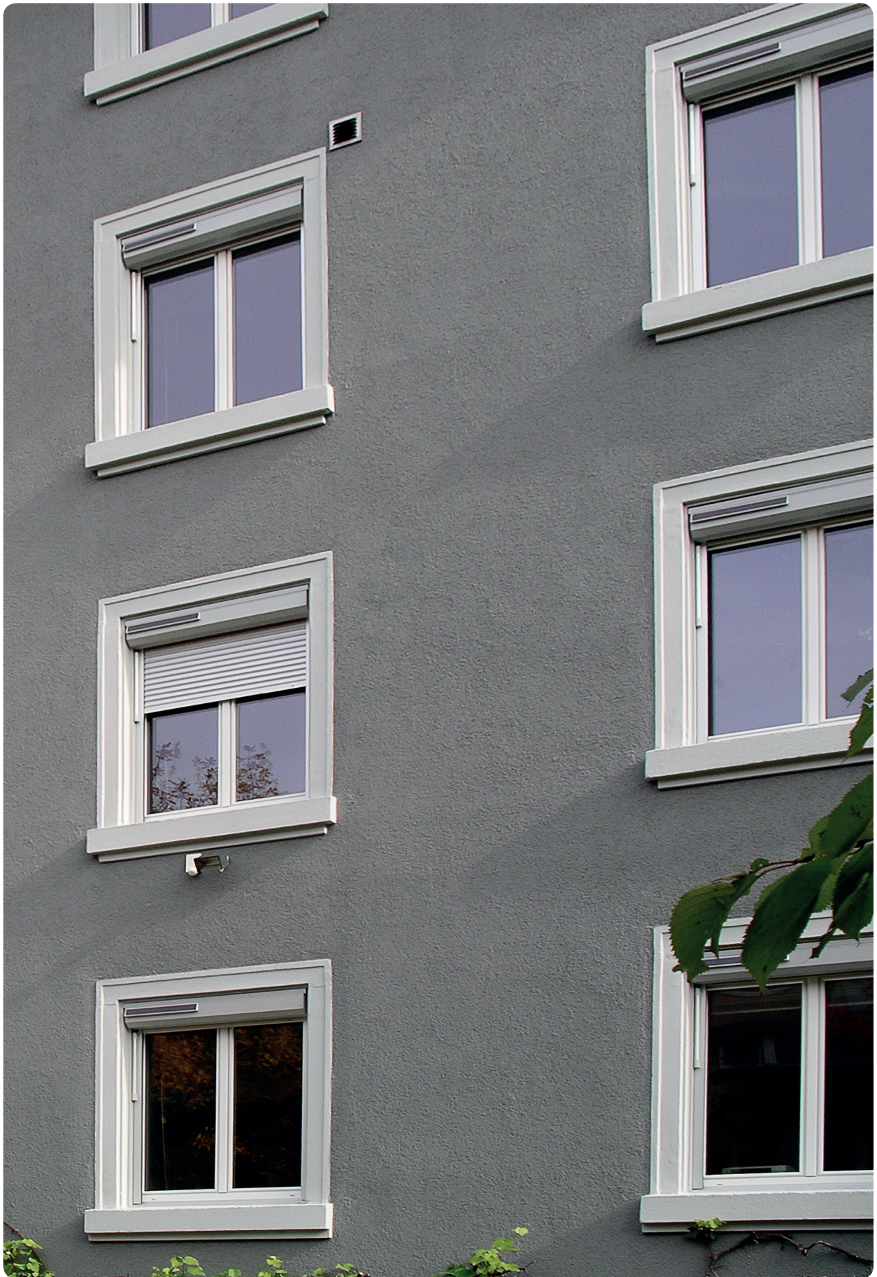
Abb. 18: Kassettenrollläden mit Solarantrieb
