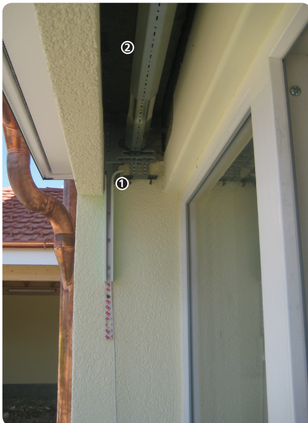
Abb. 79: Ecomont mit geteilter Führungsschiene – Phase 1
